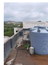
屋上の貯水槽でろ過した水を地上の蛇口から供給しています 写真提供: Rym Dada-Husseini
